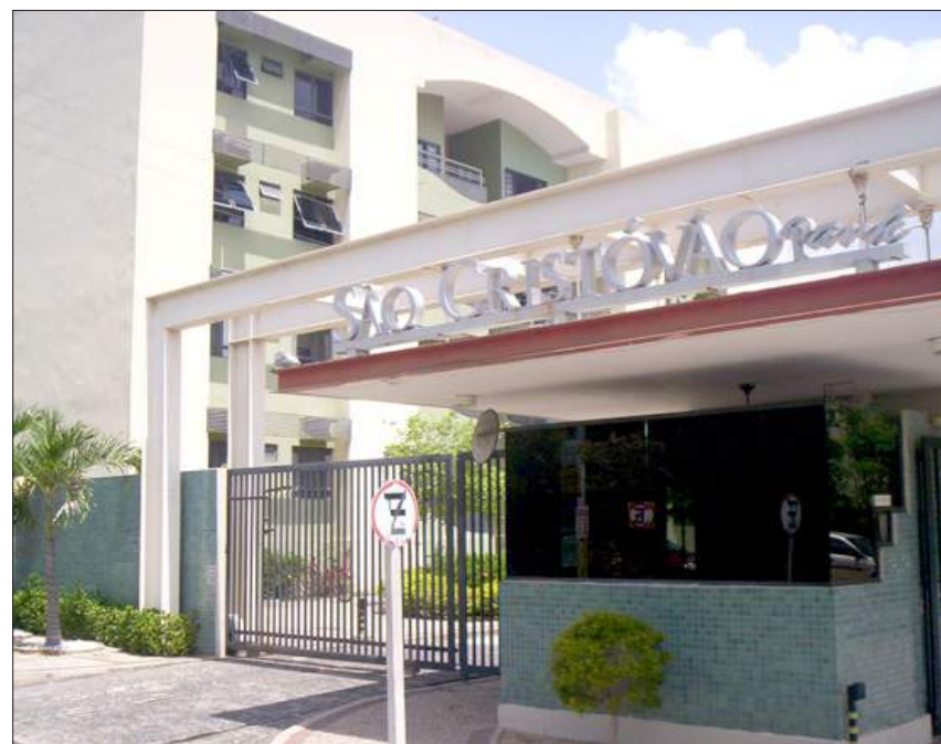
Condomínio São Cristóvão Park
